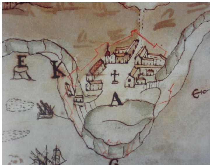
Figura 16 - Morro de São Paulo em 1626 (Fonte: Foto do autor retirado em Batalha, 2006)
